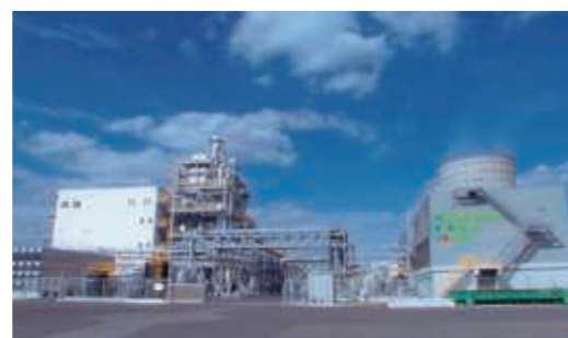
木質バイオマス発電所
